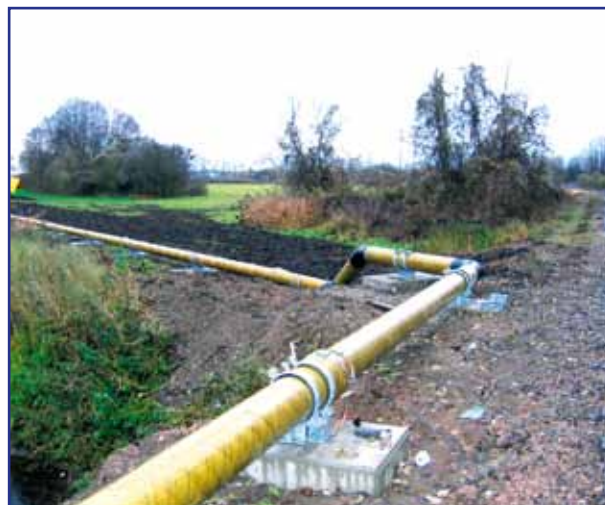
Рис. 7.4. Опора с неподвижной точкой
