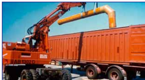
Рис. 3.2. Погрузка-разгрузка трубного узла
