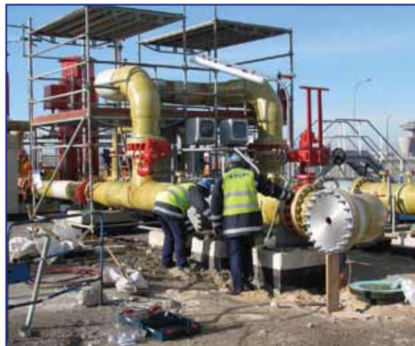
Рис. 7.1. Надземная трубопроводная система
