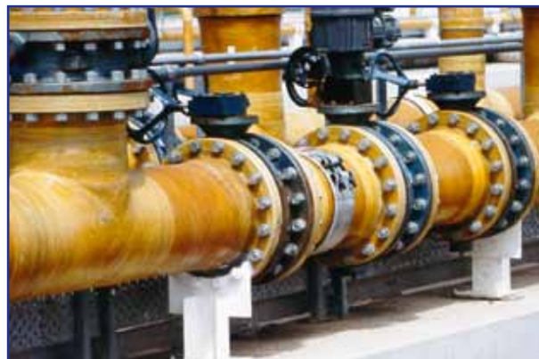
Рис. 4.4. Фланцевое соединение
