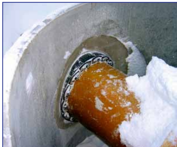
Рис. 7.13. Сочленяемое уплотнение
