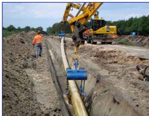
Рис. 6.5. Сборка в траншее
