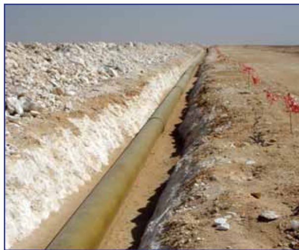
Рис. 6.2. Траншея в стабильном грунте
