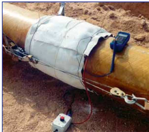
Рис. 5.5. Отверждение клеевого соединения в стянутом состоянии
