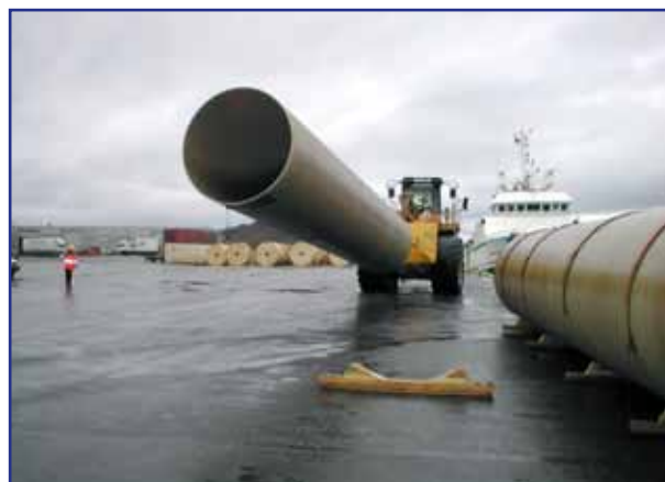
Рис. 2.5. Трубы из стеклопластика имеют малый вес
