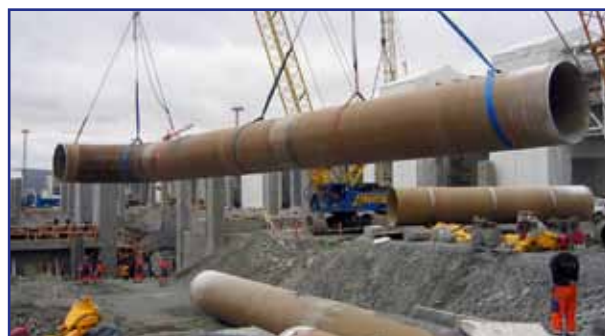
Рис. 3.4. Подъем секции с поддержкой в нескольких местах
