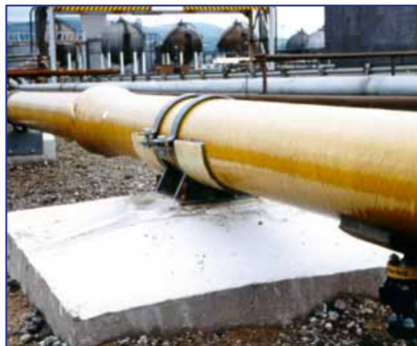
Рис. 7.5. Неподвижная точка с закрепленными хомутами
