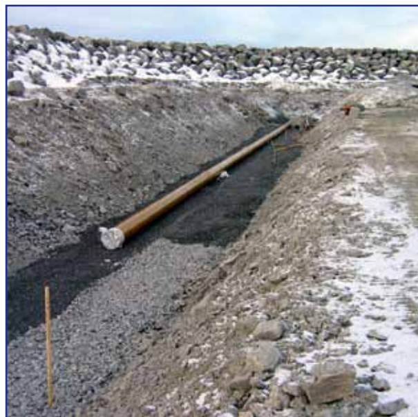
Рис. 6.8. Процесс монтажа труб в подготовленной траншее
