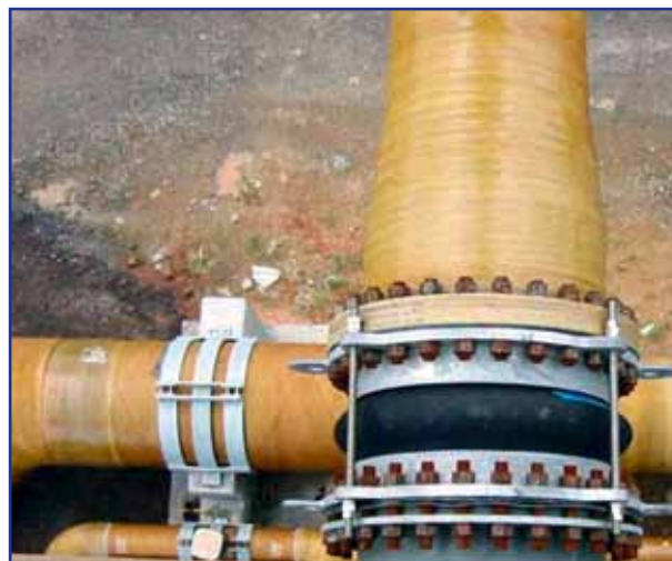
Рис. 7.9. Сильфонный компенсатор
