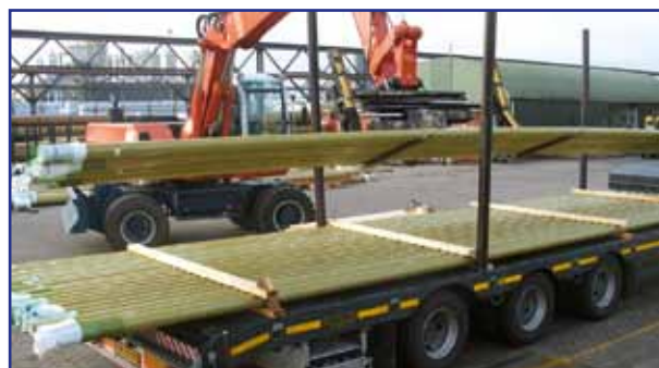
Рис. 3.3. Погрузка-разгрузка труб
