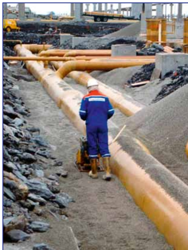
Рис. 6.9. Трамбование материала обратной засыпки
