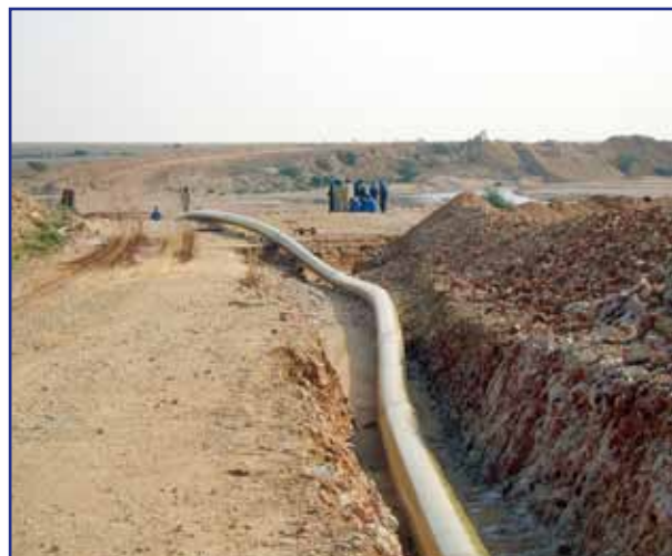
Рис. 6.13. Выравнивание трубопровода
