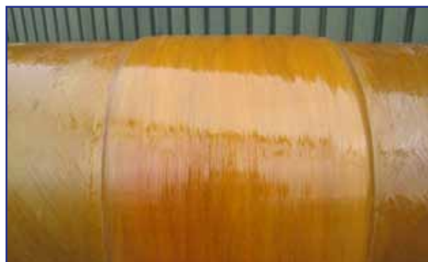
Рис. 4.3.б. Ламинированное соединение
