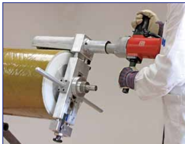
Рис. 5.2. Шлифовка гладкого ниппельного конца трубы
