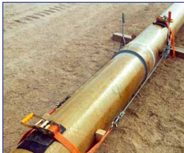
Рис. 5.4. Стянутое клеевое соединение
