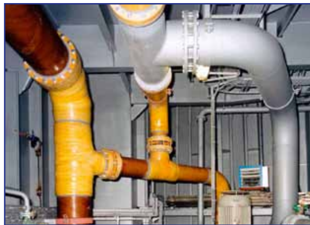
Рис. 2.6. Трубам из стеклопластика не требуется изначальная покраска или коррозионная защита
