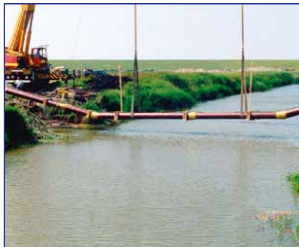
Рис. 6.12. Опускание подводной магистрали
